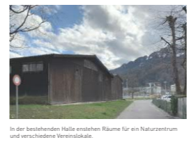
In der bestehenden Halle entstehen Räume für ein Naturzentrum und verschiedene Vereinslokale.
