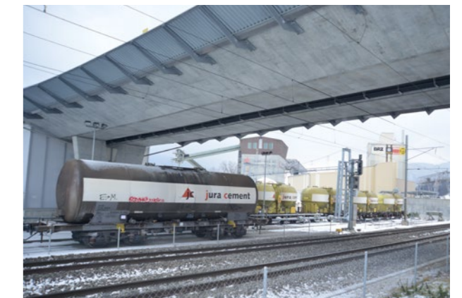
Blick vom Zentralbahntrasse unter der Kantonsstrasse
