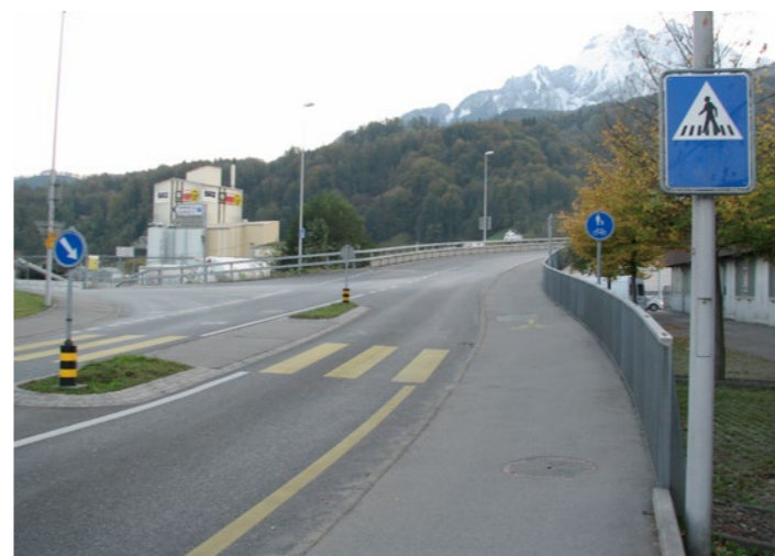
Brücke (Abschnitt 1) Richtung Technikumstrasse
