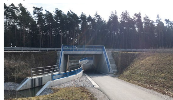
Referenz: Unterführung mit offengelegtem Bach/Kanal
